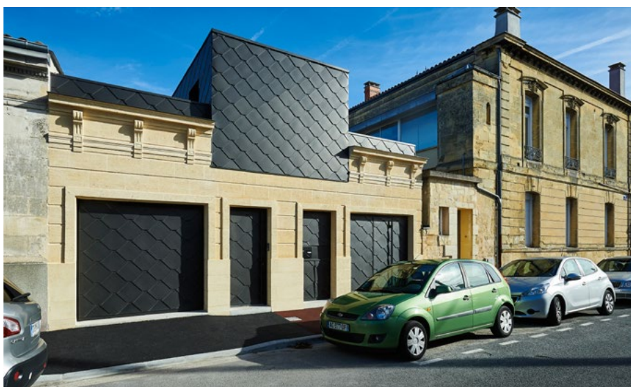
Au Bouscat également, une construction neuve mariant la pierre et un traitement contemporain du zinc.
